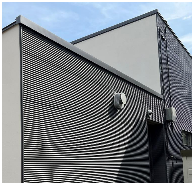
ガルバリウム鋼板 小波板横張り
