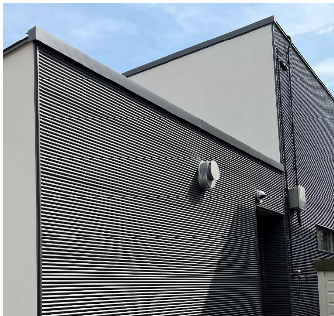
ガルバリウム鋼板 小波板横張り
