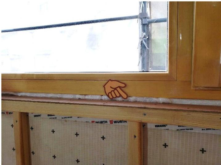
サッシと壁のすき間には膨張パッキンを施工して隙間を無くしていますが
